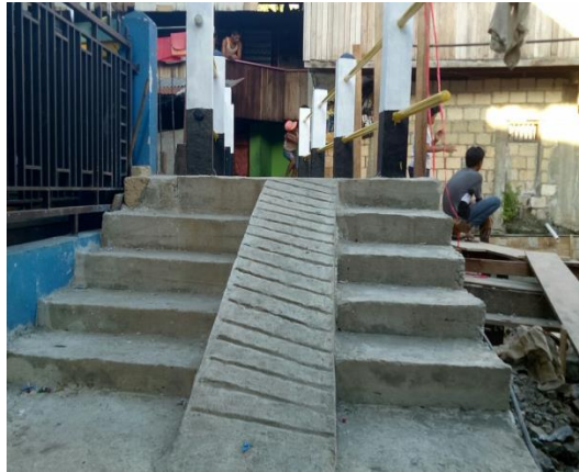
Pembangunan Jembatan RT 04/RW 06 Kelurahan Bhayangkara
