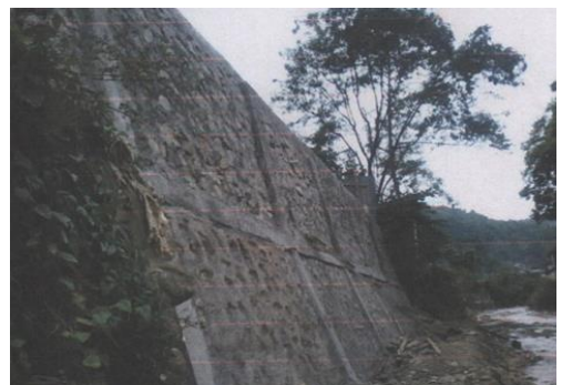
Pembangunan Talud Samping Bank Papua Jayapura Samping Gereja Overtom
