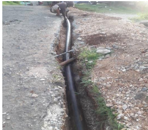
Pemasangan Pipa PE"Z" Distribusi di Hamadi Lapangan Kel.Hamadi RT.2,3/RW.6
