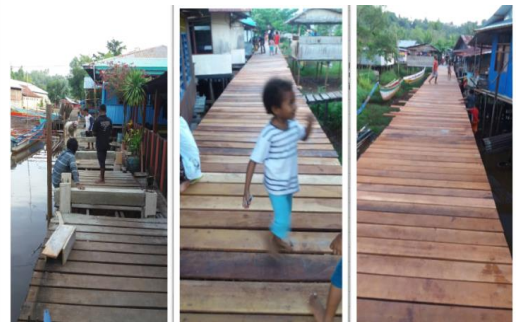
Pembangunan Jalan Jerambah Dok IX Kali RT 01/RWVII Kel. Imbi
