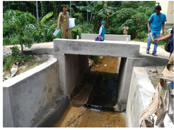
Pembangunan Talud di Kali Karva
