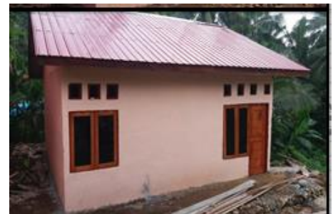
Pembangunan Rumah Layak Huni Kampung Kayu Batu (2 Unit)Kali
