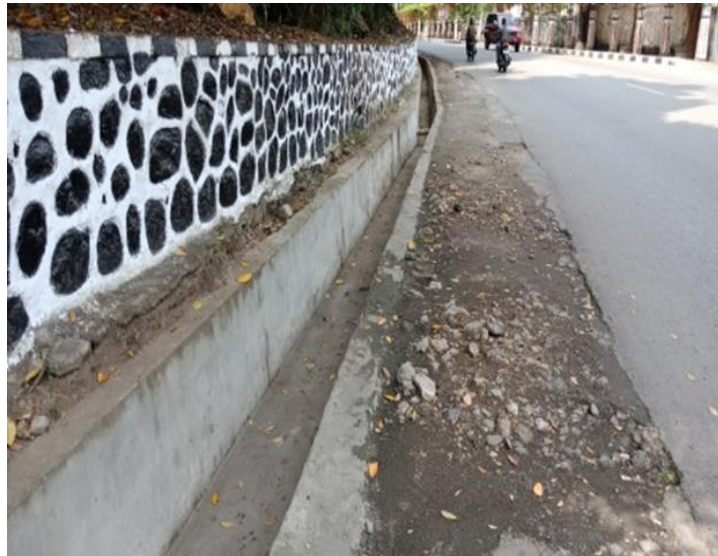
Pembangunan Saluran Drainase Kelurahan Numbay
