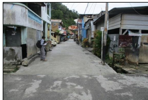
Pengecoran Jalan Lingkungan Kel. Entrop RT.05/RW5
