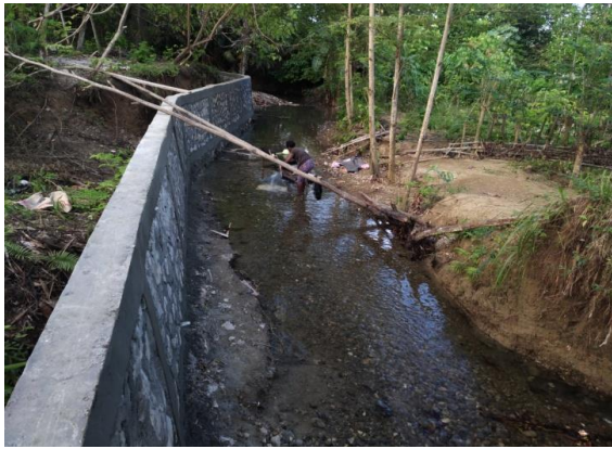
Pembangunan Talud di Kali Kampung Nafri
