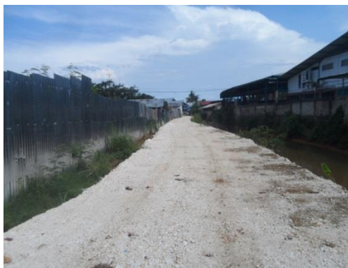
Pembangunan Jalan Inspeksi Kali Entrop ( Samping Polsek )
