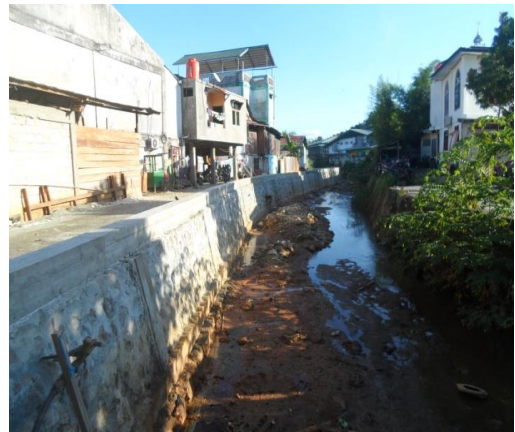
Pembangunan Talud di Kali Entrop
