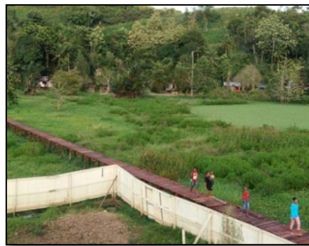
Pembangunan Jalan Jerambah Kel. Hedam
