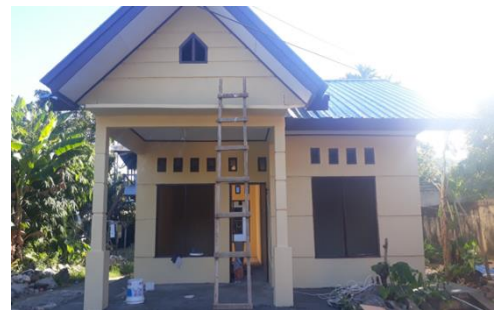
Pembangunan Rumah Layak Huni Kel. Vim Kotaraja
