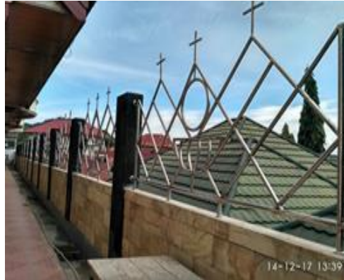
Pembangunan Pagar Rumah Ibadah RT.01/RW.03 Kel. Tanjung Ria
