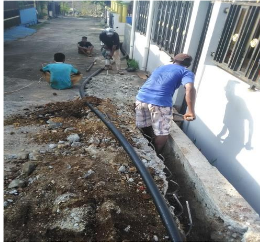
Peningkatan Jaringan Air Minum Bagi Masyarakat di Distrik Jayapura Utara
