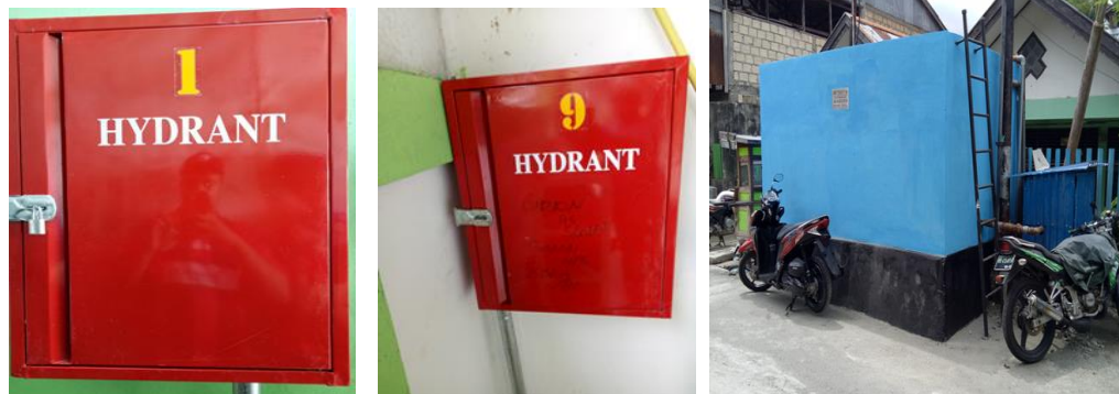
Pembuatan Hydrant di RW. V, RW VI di Kel. Gurabesi (Belakang BRI)
