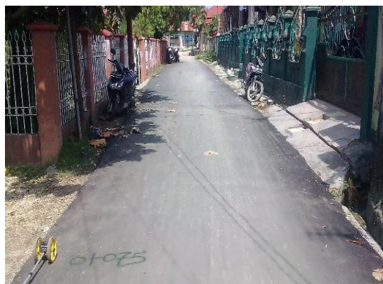
Pengaspalan Jalan Arso
