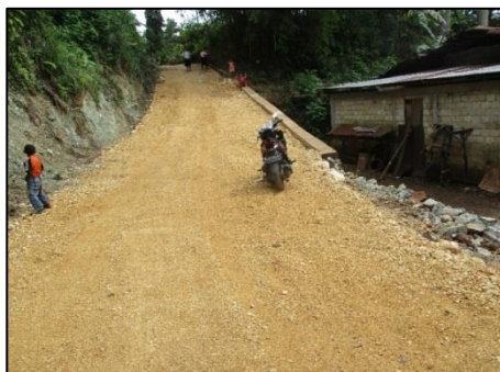
Pembangunan Jalan RT.04/RW.1 Kelurahan Imbi
