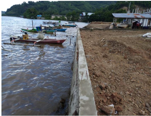
Pembangunan Talud Pengaman Pantai di Abepantai
