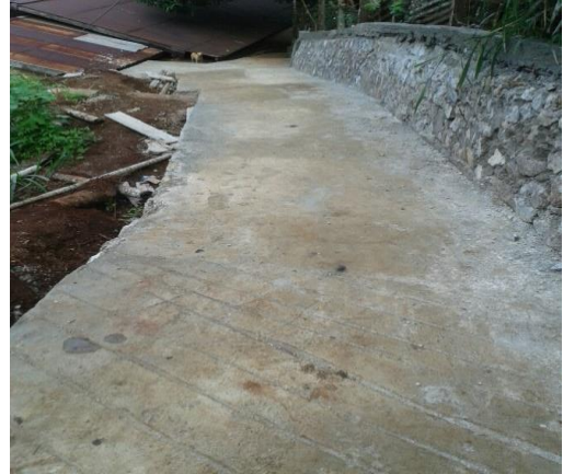
Perbaikan Jalan Lingkungan Kel.Imbi RT.3/RW.4
