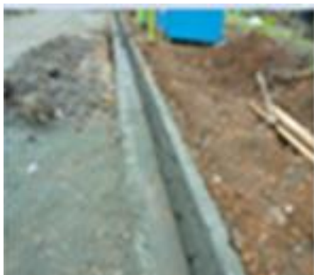
Pembangunan Drainase Kampung Buton Skyline RW.1 (230 M')
