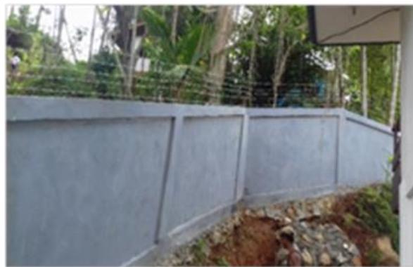
Pembangunan Pagar Pengaman Gereja Pentakosta di Tanah Papua (GPDP) Hosana Batu Putih RT.02/RW III Kel Ardipura T=1,5 M
