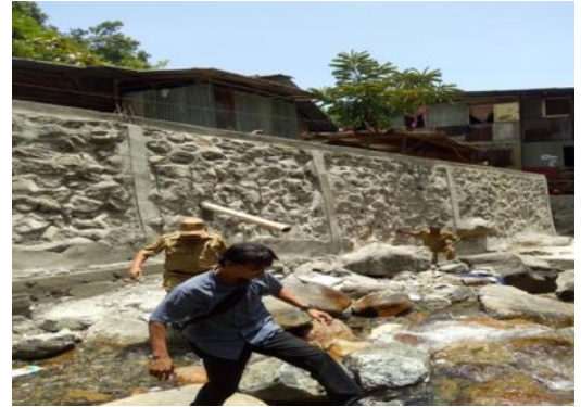
Pembangunan Talud Kel. Gurabesi RT.4/RW.5 (190M')
