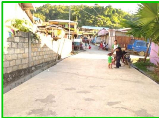
Pembangunan Jalan Penghubung RT.03/RW.02-RT.01/RW.03 Kel. Asano
