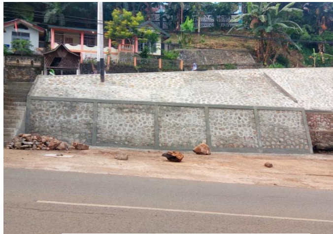
Pembangunan Talud Samping Masjid al Taqwa Jalan Masuk SMA 2
