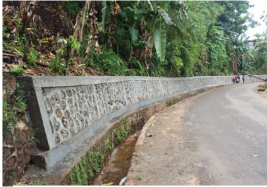
Pembangunan Talud di Jalan Sampan Dok IX Atas Kel. Imbi RT.1/RW.4 (190M')
