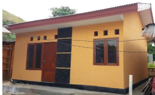
Pembangunan Rumah Layak Huni RT.03/RW.03 Kampung Waena
