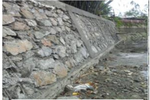
Pembuatan Talud Bisoka II Kel. Wahno RT.4/RT.5 (167 M')
