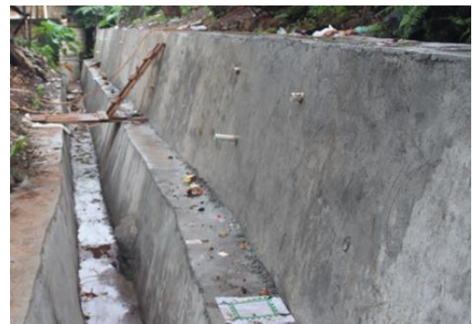
Pembangunan Talud Kampung Moso (100 M)
