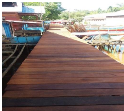
Pembangunan Jalan Jerambah Kel. Imbi (79 M2)
