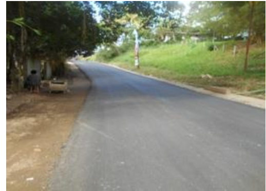
Peningkatan Jalan RW VI Perumnas Korem Waena
