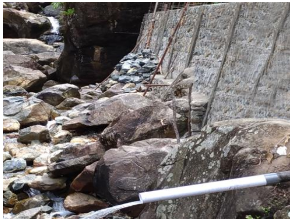
Pembangunan Talud di Kali Kampung
