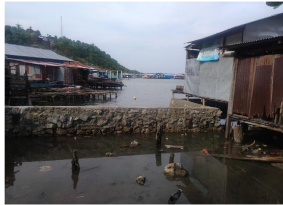
Talud Penahan Gelombang Pantai Argapura
