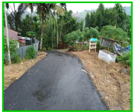
Pengaspalan Jalan Lingkungan Bisoka II kel.
