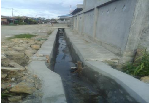
Penimbunan dan Pembuatan Talud Kel. Waena Jalan Belut Expo (190 M')
