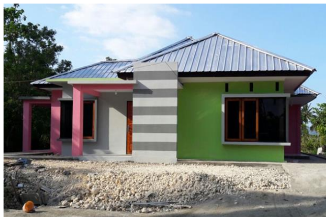
Pembangunan Rumah Eks Ketua Sinode GKI (226 M2)
