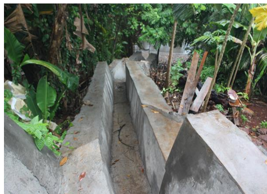
Perbaikan Talud dan Perbaikan Jalan Lingkungan Kel.
