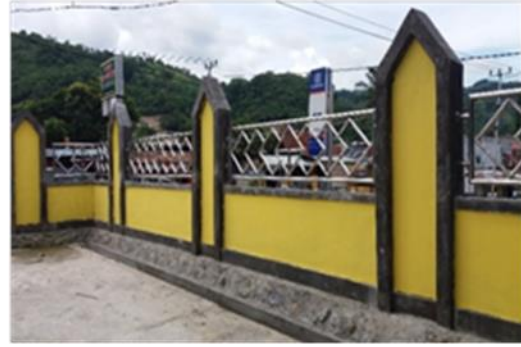
Pembangunan Pagar Gereja ElShadai Tanah Hitam
