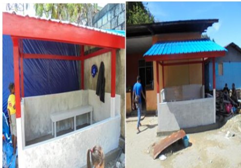
Pembangunan Pos Jaga
