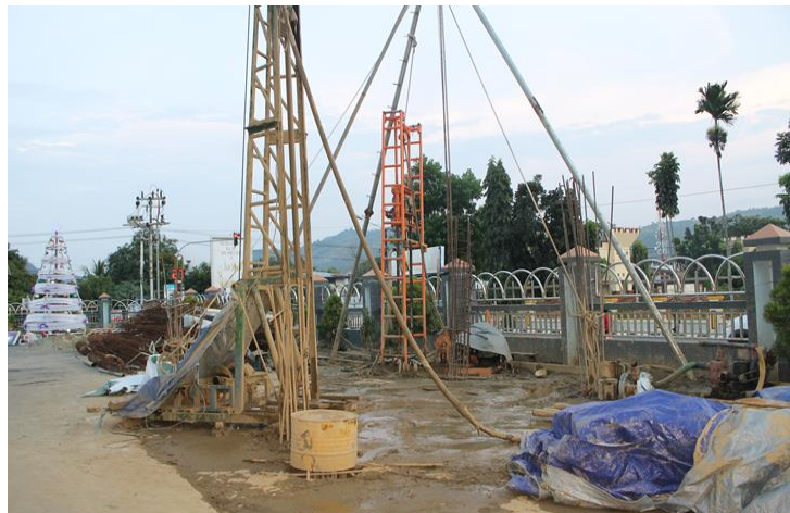
Pembangunan Menara Gereja PNIEL
