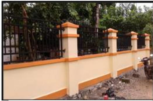
'Pembangunan pagar SD YPPK Santo Petrus Argapura T=1,5 M
