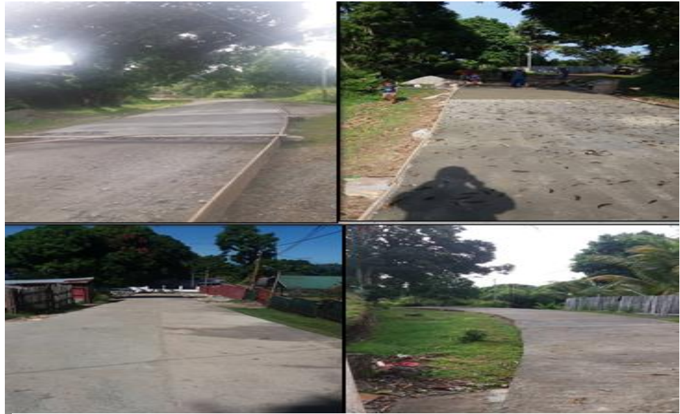
Pembangunan Jalan Lingkungan RT.03/RW.III Kel. Trikora
