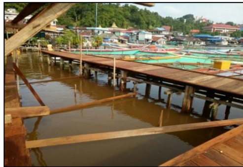
Pembangunan Tambatan Perahu Nelayan Pasar Inpres Tanjung Ria
