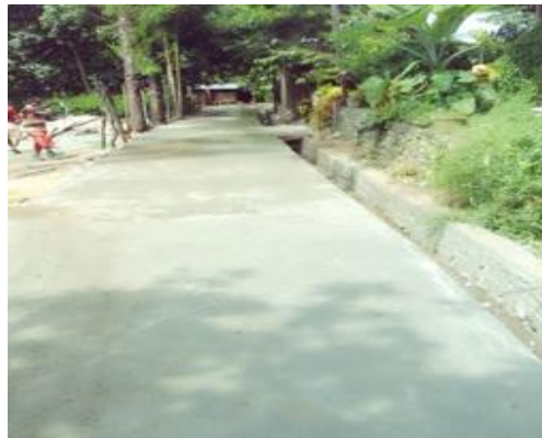
Pembangunan Talud, Drainase dan Cor Jalan Kelurahan Yabansai RT.2/RW.3
