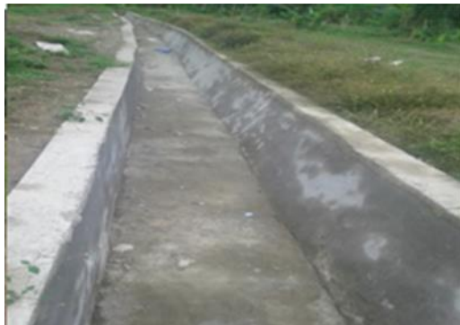
Pembangunan Saluran Drainase Kel. Abepantai RW.1 RW.3/ RT.1 & 2 & 3
