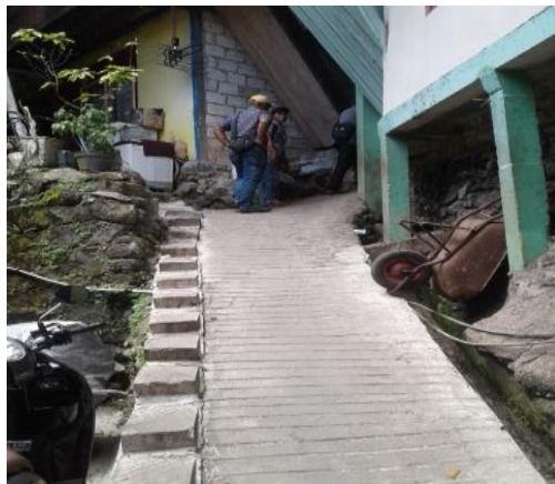
Perbaikan Jembatan dan Jalan Lingkungan Kel.Bhayangkara RT.2/RW.1
