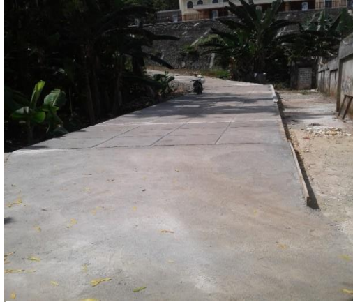
Peningkatan Jalan ( Pengecoren Jalan ) Kel.Bhayangkara RT.3.5/RW.5
