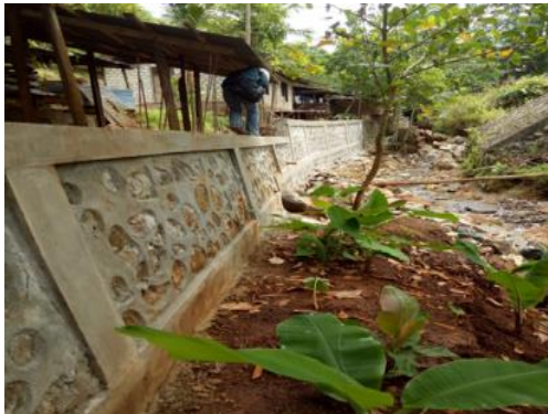
Pembangunan Talud Kelurahan Angkasa RT.7/RW.2
