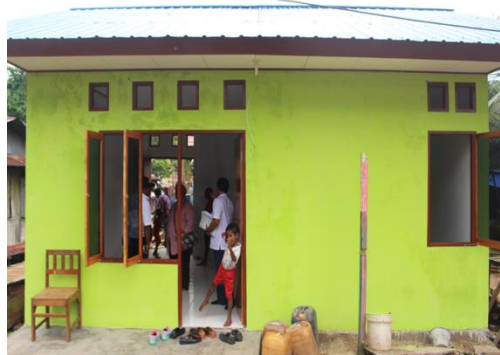
Pembangunan rumah layak huni kel. Tanjung Ria RT.5 RW.5
