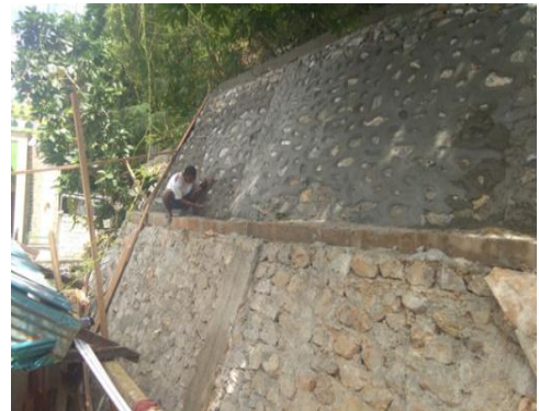
Pembangunan Talud Pasar Ikan Dok IX Kelurahan Tanjung Ria RT.5/RW.1
