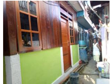
Pembangunan rumah layak huni kel. Tanjung Ria RT.3 RW.5 dan Dok IX Kali
