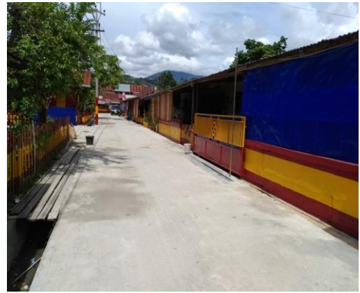
Pengecoran Jalan di Komp. Asrama Brimob Kotaraja
