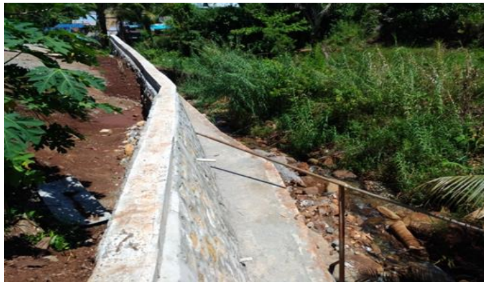
Pembangunan Talud Sungai Dok IX Kali Kel. Tanjung Ria
