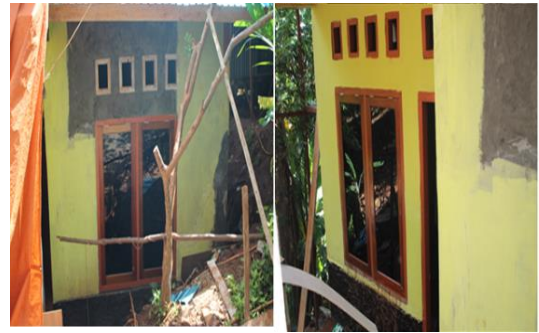
Pembangunan Rumah Tinggal Ribka Kareth Kel. Tanjung Ria
