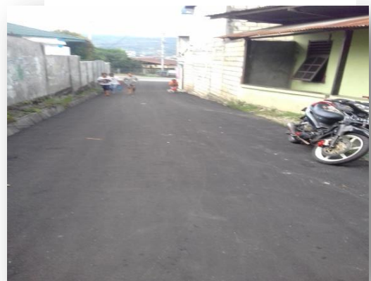
Pengaspalan Jalan Kel. Awiyo
