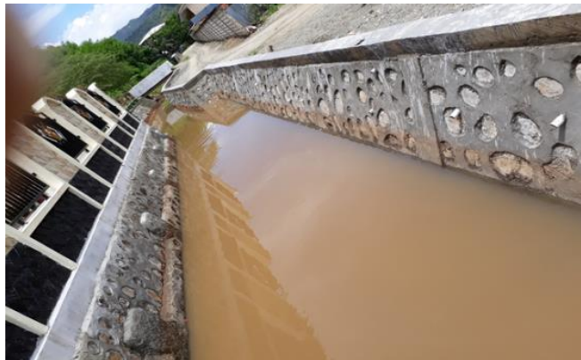
Pembangunan Talud Dekat Gereja GBI Kompleks Uncen Bawah RT.01/RW.06 Kelurahan Kota Baru
