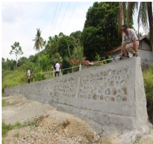
Pembangunan Talud Depan Kantor Kepala Kampung Koya Koso
