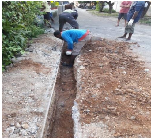
Pemasangan Pipa PE"Z" Distribusi di Hamadi Lapangan Kel.Hamadi RT.2,3/RW.6
