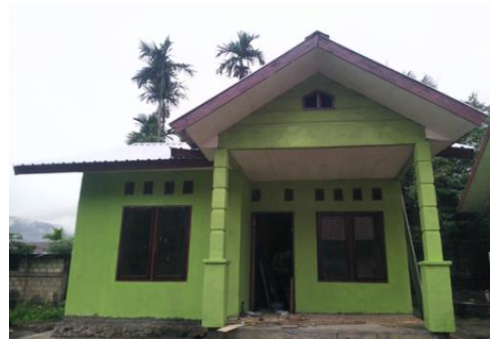
Pembangunan Rumah Layak Huni Kampung Kayu Batu
