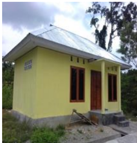
Pembangunan RumahJaga UPTD TPA dan IPLT Koya Koso
