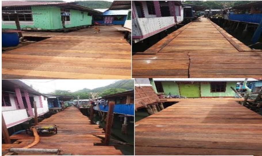
Pembangunan Jalan Jerambah Kel. Argapura
