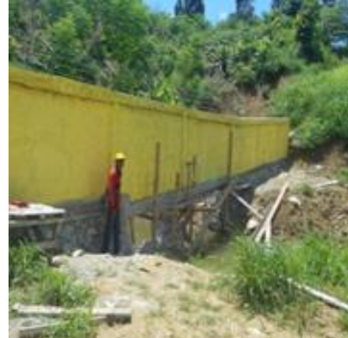
Pembangunan Pagar Lahan UPTD TPA dan IPLT Koya Koso
