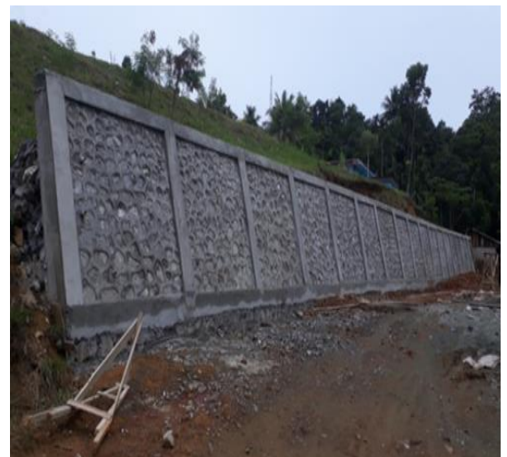
Pembangunan Talud RT.03/RW.01 Kelurahan Wahno
