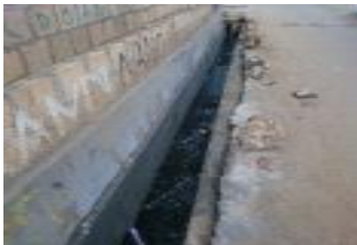
Pembangunan Talud Kel. Vim RT 004 / RW 001 P=150 M dan RT 005 / RW 004 P=50 M dan RT 001/ RW 008 P= 100 M
