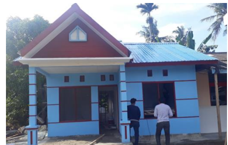
Pembangunan Rumah Layak Huni Kampung Mamberamo Koya Timur
