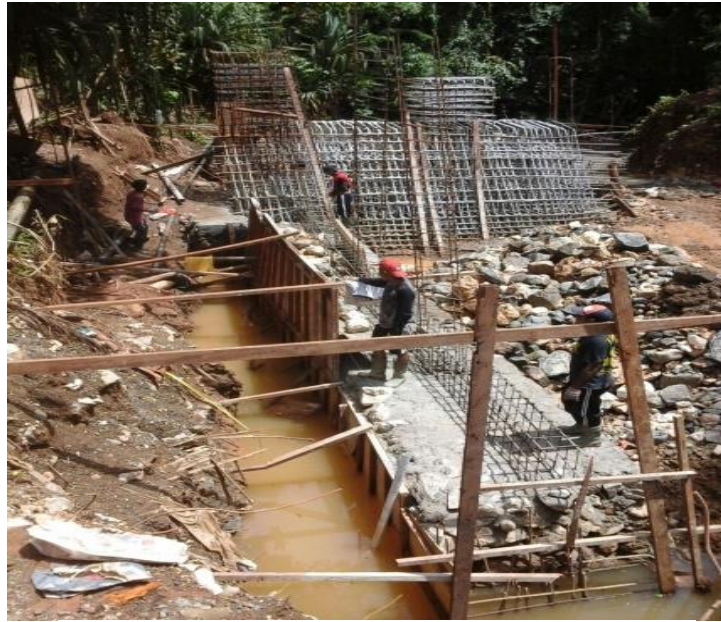
Pembangunan Cek Dam
