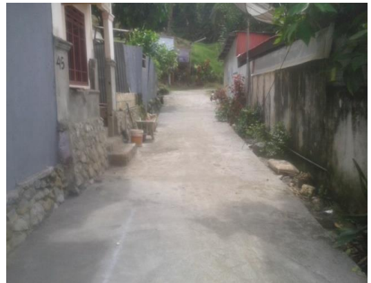
Pengecoran Jalan Lingkungan Gang Deho & Kakatua Perumnas III
