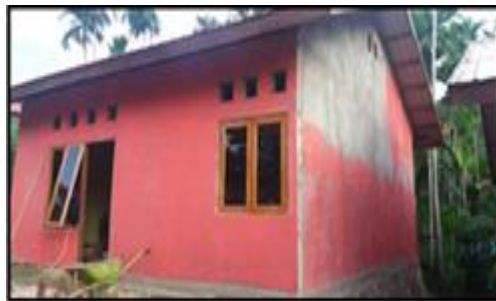
Pembangunan Rumah Layak Huni Type 36 Kel. Tanjung
