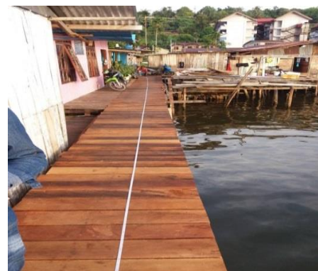
Pembangunan Jalan Jerambah Kel. Tanjung Ria
