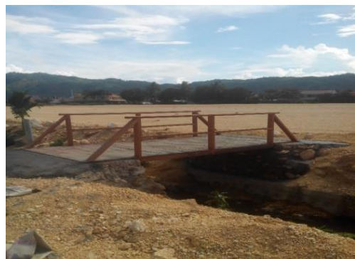
Jembatan Kayu 5 Unit di Pasar Yotefa Baru
