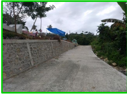
Pembangunan Jalan Pekuburan Kristen Abepura
