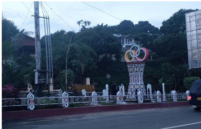
Pembangunan Taman Numbay
