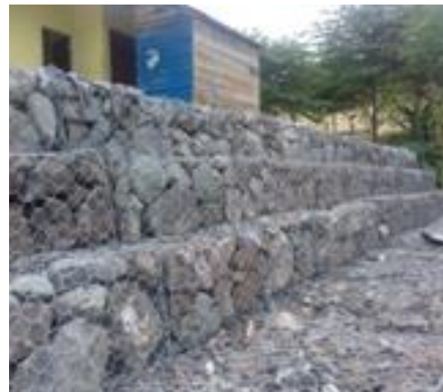
Pembangunan Talud UPTD TPA dan IPLT Koya Koso
