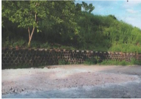
Pembangunan Talud Dermaga Kali Acai
