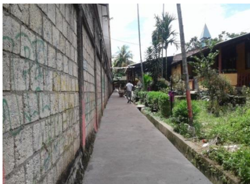
Perbaikan Jalan Lingkungan Perhubungan Gereja Harapan ke Jalan Kokas
