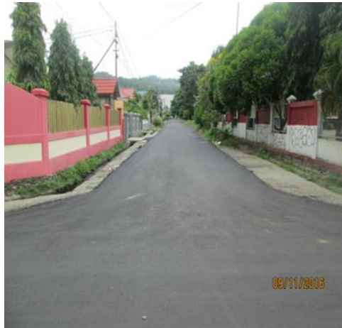
Peningkatan Jalan Cigombong
