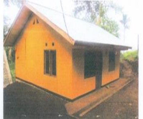
Pembangunan Rumah Layak Huni Kel. Angkasa RT.1 RW.2
