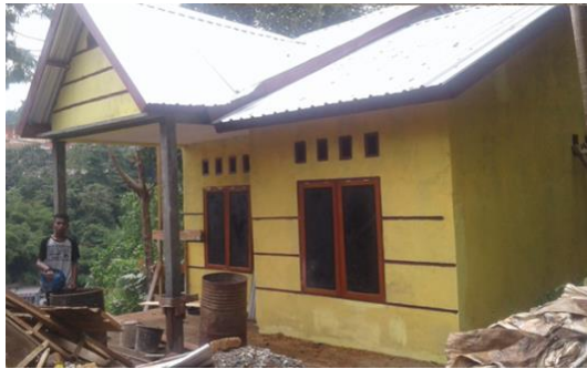
Pembangunan Rumah Layak Huni RT.V/RW.VI Kel. Gurabesi
