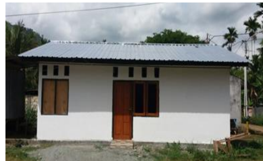
Pembangunan Rumah Layak Huni Kampung Yoka
