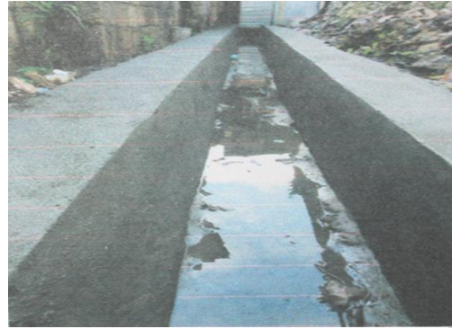
Pembangunan Saluran Drainase Lingkungan Parit RT.6/RW.5 Kel. Hamadi (210 m')
