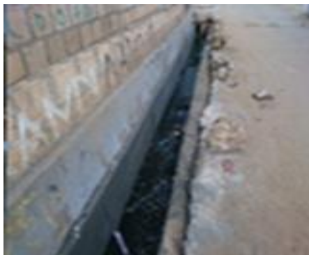
Perbaikan Drainase Jl. Merak Kotaraja Kelurahan Vim RT.1,8/RW.1 (180M')
