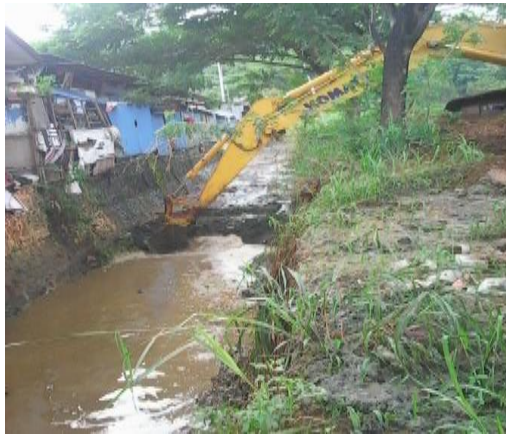
Pengerukan Sedimen Samping Terminal Sampai PTC Entrop
